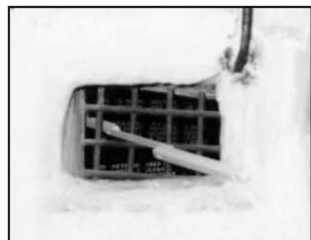
Obr. 98: Zamřížovaný otvor ve stěně místnosti I odvšivovacího baráku 41 v Majdanku (viz plánek na obr. 95).
