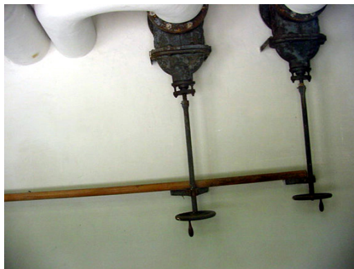
Obr. 10: Silně izolované teplovodní (nebo parní?) potrubí v místnosti za údajnou plynovou komorou v Dachau, vedoucí do prostoru nad místností. 34
