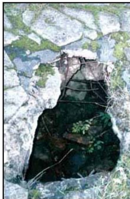
Obr. 57: Údajný otvor na vřazování cyklonu B ve střechě márnice 1 („plynové komory“) krematoria II, vstup do ještě dnes přístupné části sklepa.
