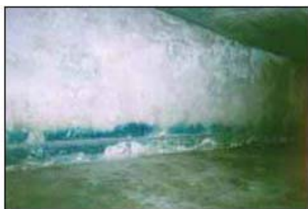
Obr. 49: Odvšivovací zařízení (cyklonem B), komora III (východní zeď) baráku 41 v Majdanku. (© Carlo Mattogno) 143
